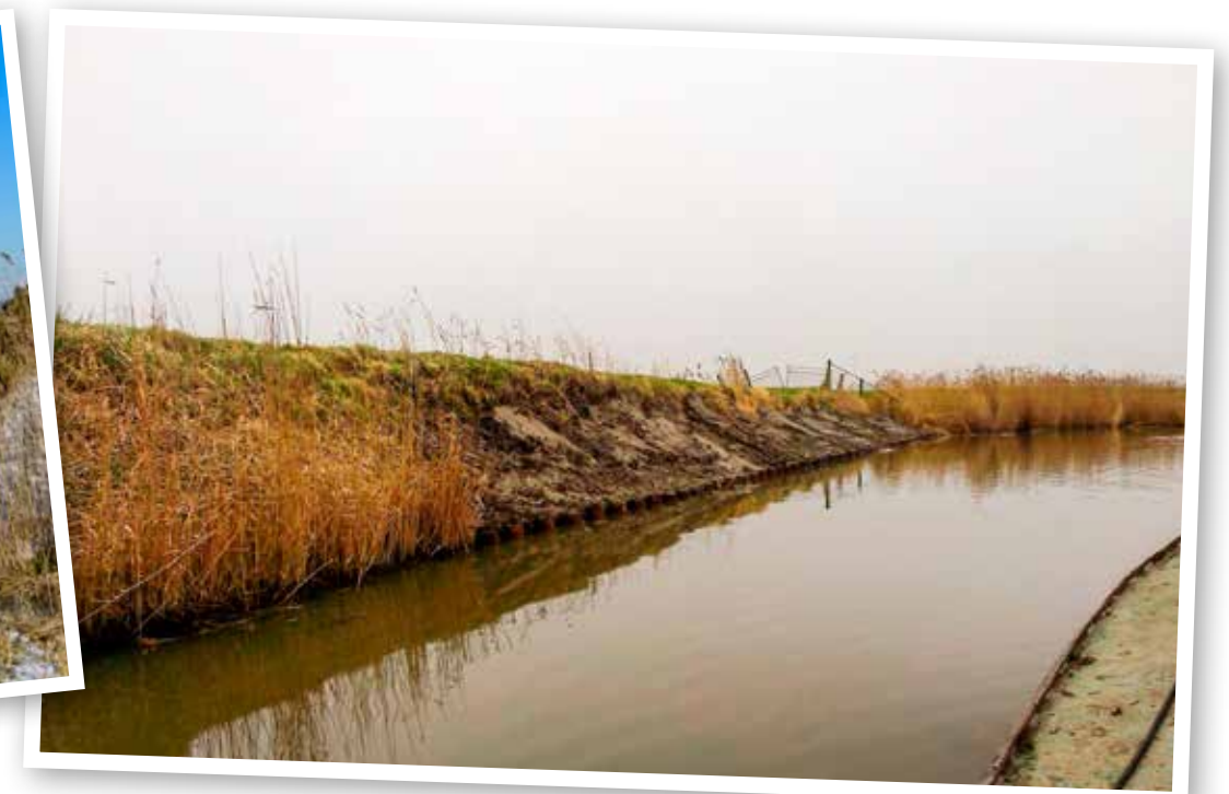
Nieuwe walbeschoeiing ter bescherming van de dijk
