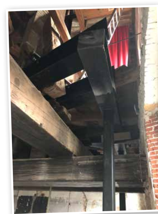
Deel staalconstructie tafelmant
